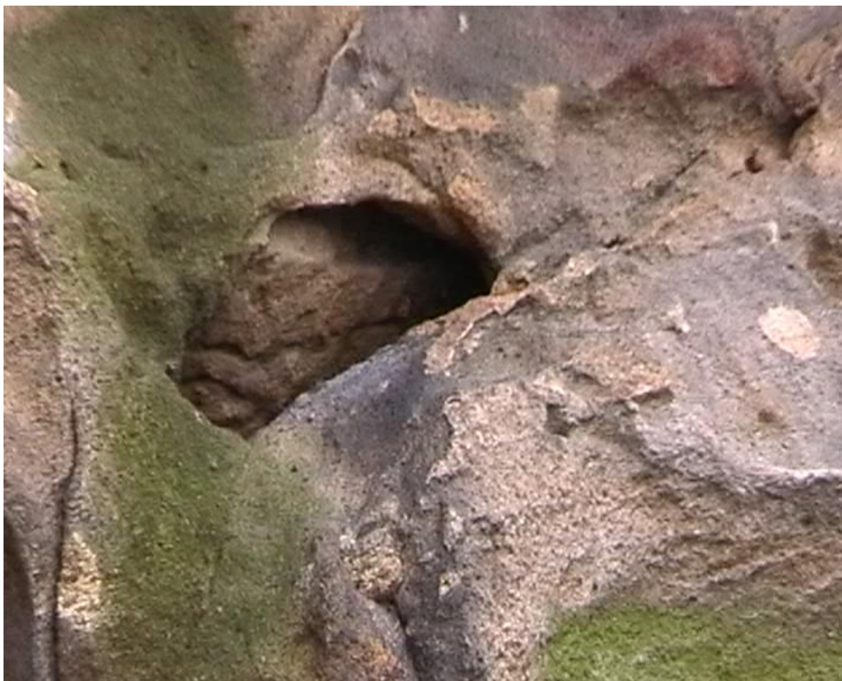
Obr. 20. Odlomená část přizdívky odkrývá jakoby zazděný blok jemnozrného pískovce který se zdá být kamenicky zpracovaný. Materiál „malty“ je místy napaden mechovým náletem a zbarven zeleně.
